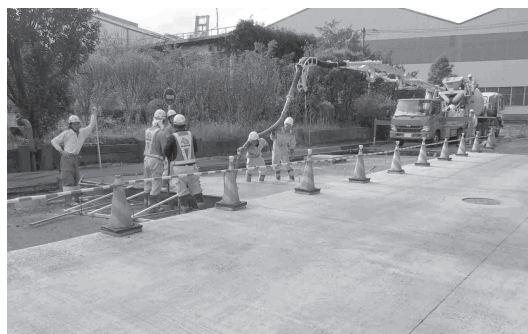
写真5 フェロフォーム®のポンプ打設 Photo 5 Placing Ferroform™ by pumping
