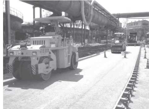
写真3 転圧ローラーによる転圧 Photo 3 Roller compaction
