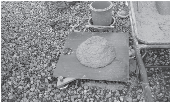
写真4 スランプ試験 Photo 4 Slump test
