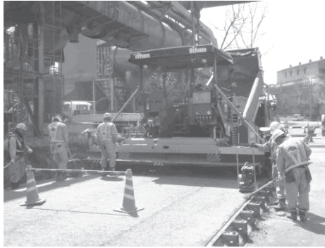
写真2 アスファルトフィニッシャーによる敷均し Photo 2 Laying Ferroform™ with asphalt finisher
