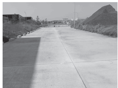
写真7 施工後の舗装版
